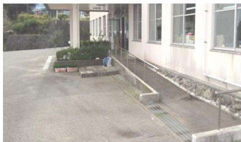
本館 玄関入口 スロープ
