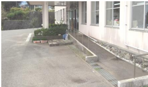
本館 玄関入口スロープ
