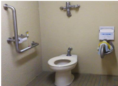
本館 1F トイレ
