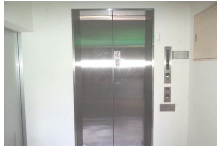
本館 エレベーター
