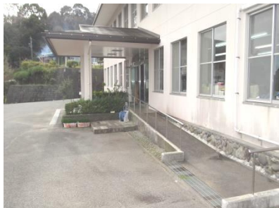
本館 玄関入口スロープ
